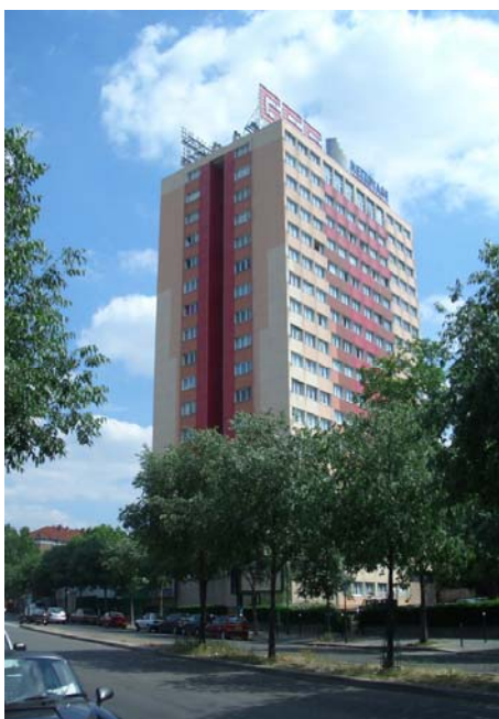
Tower Bois le Prêtre : Existing building
